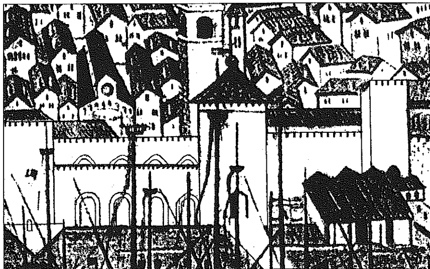
fig. 4 - Gli arsenali del porto di Ragusa all'inizio del XVI secolo. Un particolare del trittico di Nikola Boidarevi Madonna con Santi , del primo Cinquecento. Nella figura si vede il muro est del grande arsenale con gli archi ovali, costruito tra XV e XVI secolo. Il muro con archi acuti, in seguito alla costruzione del nuovo recinto, perse la sua funzione. Da nord l'arsenale era protetto dalla Torre della pescheria (abbattuta nel 1853) e da sud dalla Torre della penitenza. Il piccolo arsenale è a destra.
