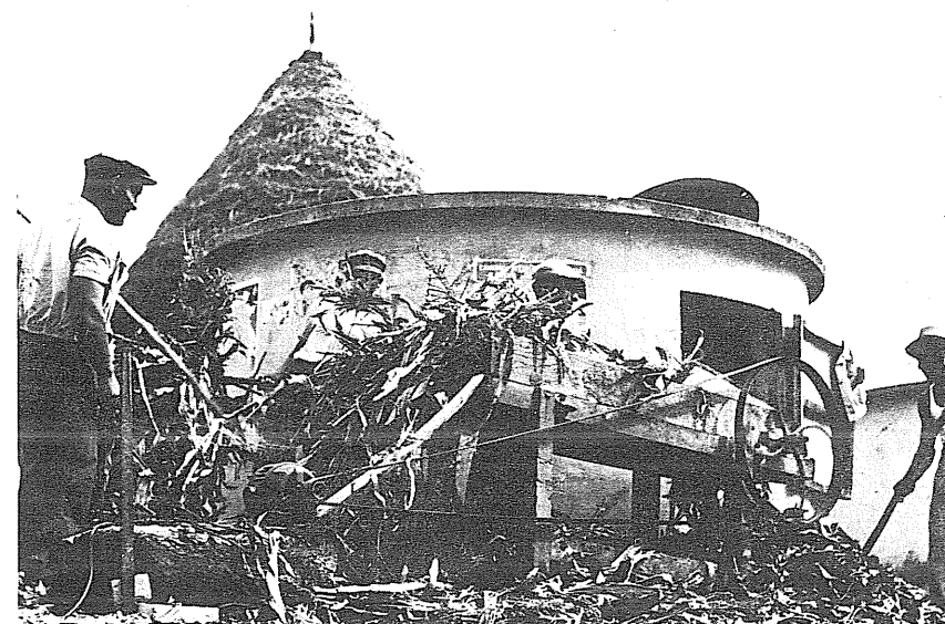
fig. 2 - Trinciaforaggi azionato da motore elettrico (1936), Archivio dell'A.S.S.M. di Tolentino.
