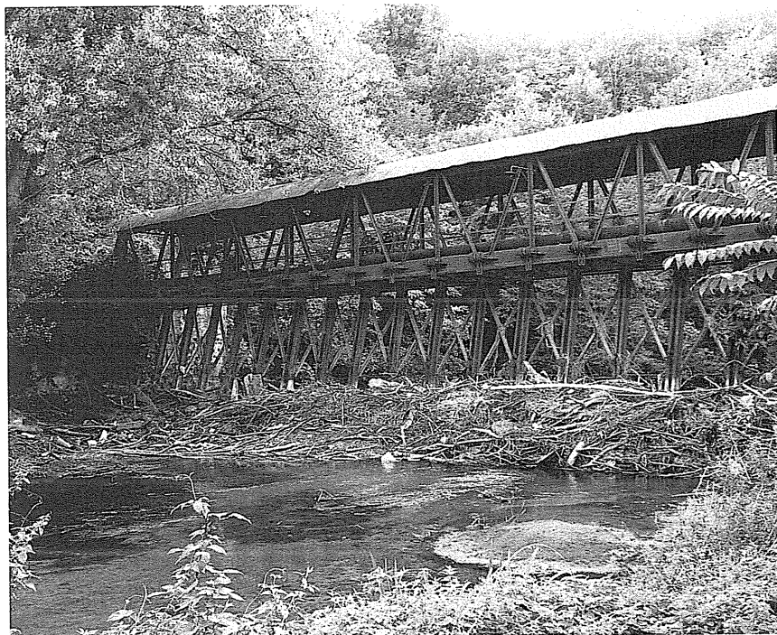
fig. 4 - Il ponte diga, così come visibile oggi.
