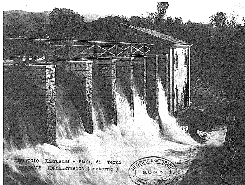
fig. 3 - Sforatore del canale Nerino e centrale esterna dello Iutificio Centurini.
